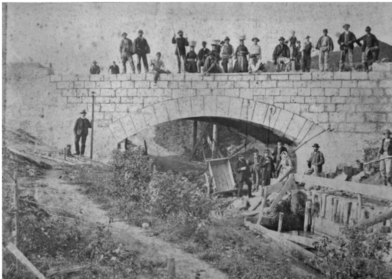
1871 Bau des Aquädukts in der Einöde für die 1. Wr. Hochquellwasserleitung
